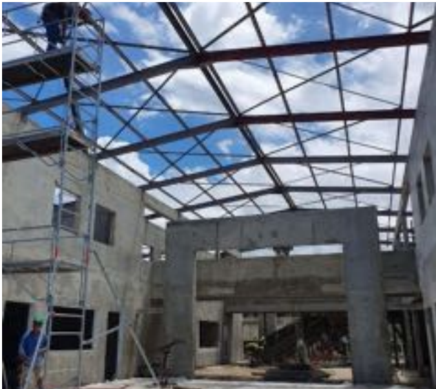
Ce jeudi... 24 ème réunion de chantier... la charpente est fixée
