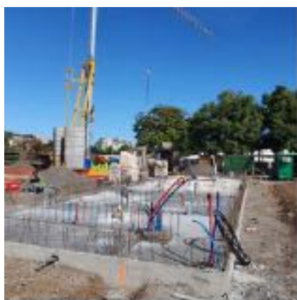
dallage aile nord coulé
