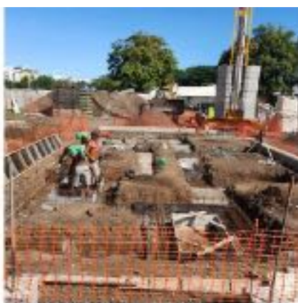
Préparation fondations aile SUD
