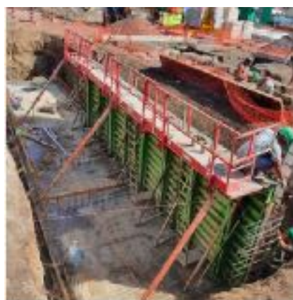
Pose banche pour voie fosse en cours
